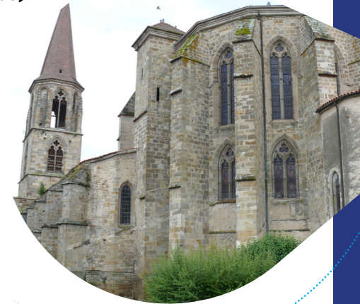
Commune de Billom Eglise Saint-Loup
