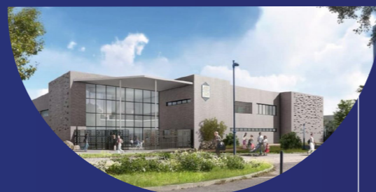
Ville de Toulouse (31) Construction de l'École élémentaire Jean Zay
