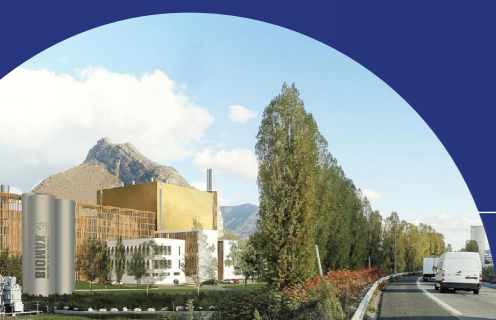
Grenoble Métropole (38) Construction d'une centrale de cogénération
